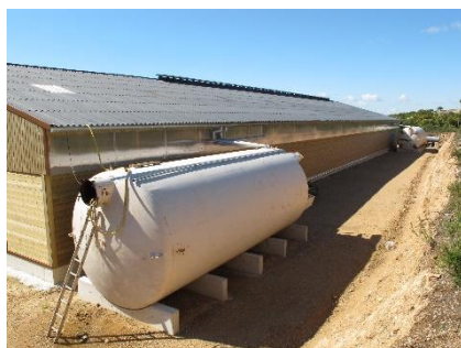
Cuve de récupération des eaux de pluie sur une bergerie Chambre d'Agriculture de l'Hérault - Petit J.C.
