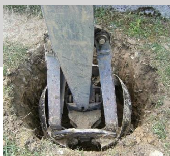
Forage en cours
